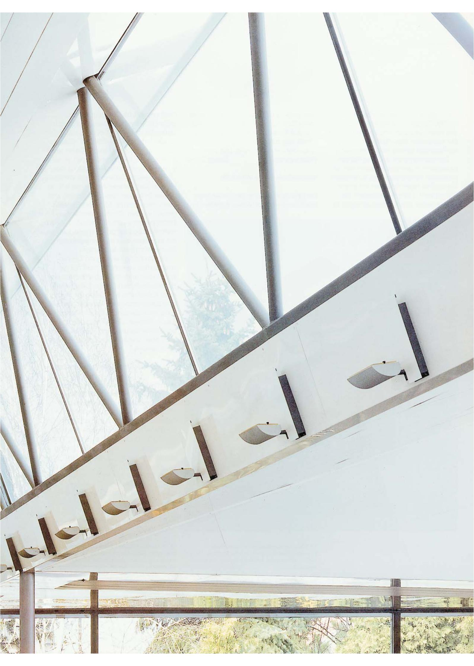
Dach. Da die Sprossen als Koppelstütze (mittige Verglasung) ausgebildet sind, ergibt sich innen wie außen eine schlanke Ansicht. Die reduzierten Maße behindern von keiner Seite den Einblick in den Innenraum.
