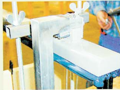
Verklebung der Fassadenscheiben mit den Deckleisten bei Bischoff Glastechnik in Bretten. Die Lehren wurden von der Firma Brandl angefertigt.
